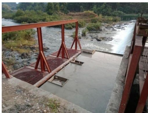
Hình 14. Cải tạo lắp đặt máy bơm tại hệ thống thủy lợi Thác Dắng
